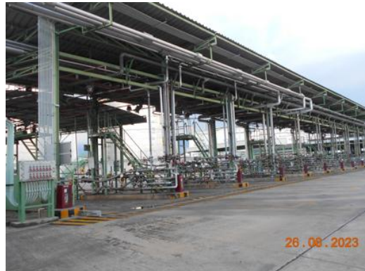
รูปที่ 1.8.7-1 สถานีสูบล้างเคมีภัณฑ์ลงรถแท้งค์ (Lorry Station)
