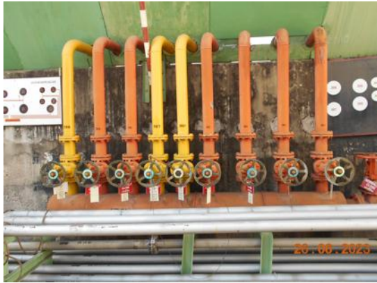
รูปที่ 1.8.3-11 ท่อดับเพลิง และ Air foam Header Zone 5 : D – Area
