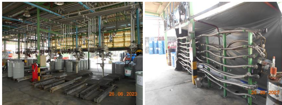
รูปที่ 1.8.7-2 สถานีจ่ายเคมีภัณฑ์ลงถัง 200 ลิตร (Drum Station) มีการติดตั้งพัดลมระบายอากาศที่บริเวณสถานีบรรจุเคมีภัณฑ์ลงถังเหล็ก
