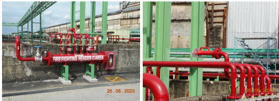
รูปที่ 1.16.2 ติดตั้ง Header ตัวใหม่ บริเวณ Area-C
