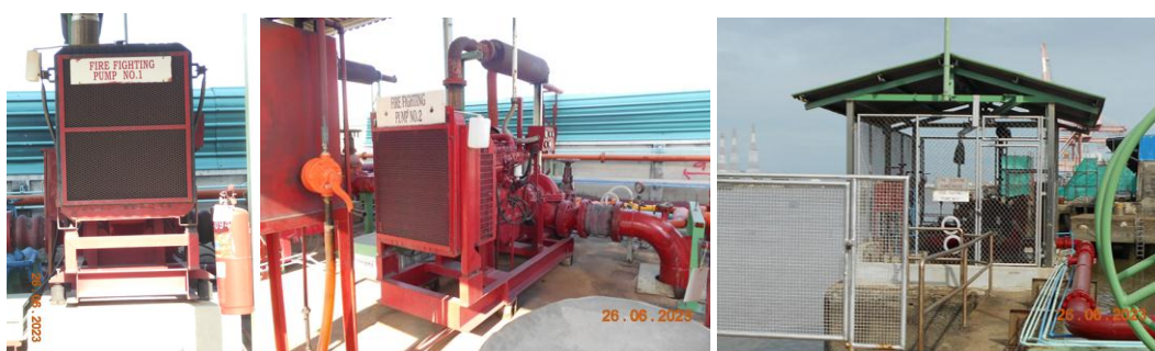
รูปที่ 1.8.10-1 เครื่องสูบน้ำเครื่องที่ 1, 2 และ 3 ตามลำดับ (Fire Pump)
