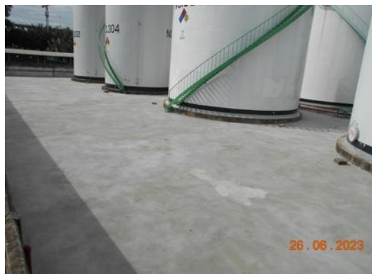
รูปที่ 1.16.5 ทำพื้นทางเดินที่บริเวณ Area-D เป็นพื้นคอนกรีต
