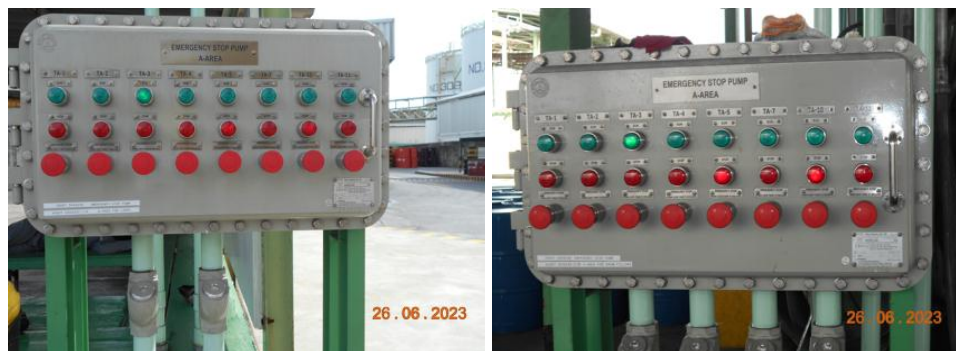
รูปที่ 1.16.4 ติดตั้ง Emergency stop pump บริเวณโรงเติมรถและโรงเติมถังของ Area-A
